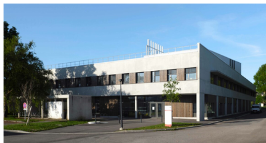
Le pôle AgroBioSciences (PABS-B), bâtiment plan campus UT sur le campus INRAE d'Auzeville Tolosane
